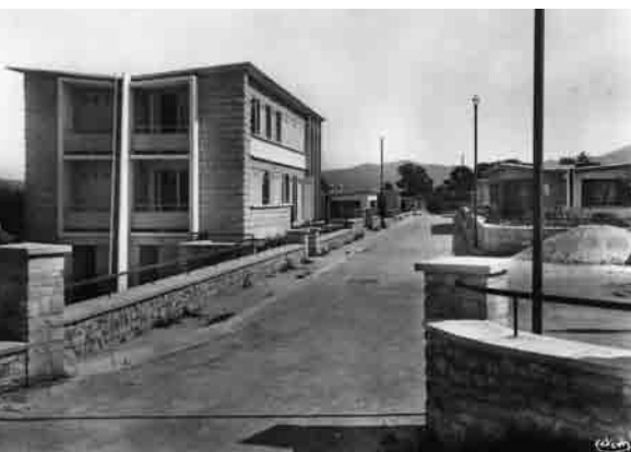
L'hôtel des ingénieurs, à Bagnols-sur-Cèze. Etat d'origine, Ville de Bagnols-sur-Cèze.
